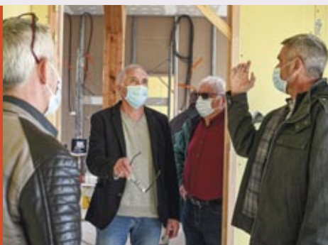
Visite sur le chantier du futur Centre de Santé Municipal le 4 mars.
