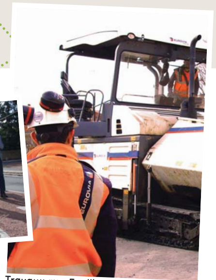
Travaux rue Fouilland.
