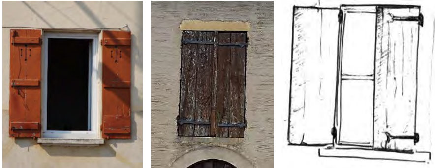
modèles de volets traditionnels à lames simples ou croisées
