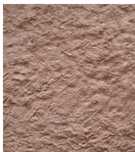
enduit jetée à la truelle
