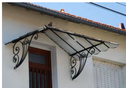
exemple de marquise en verre et fer forgé adaptée à l'architecture...
