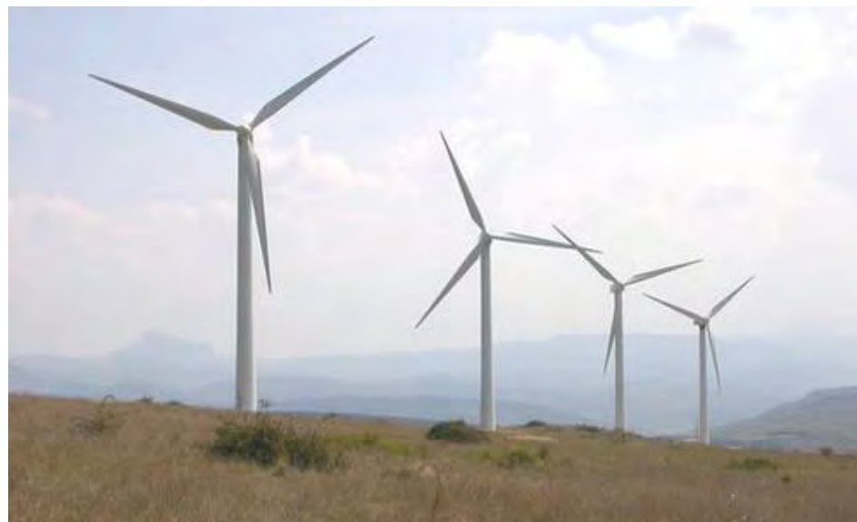
Impact sur le paysage d'un champ d'éolienne sur une ligne de crête Source internet
