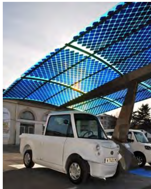
Ombrière photovoltaïque sur un parking Source internet
