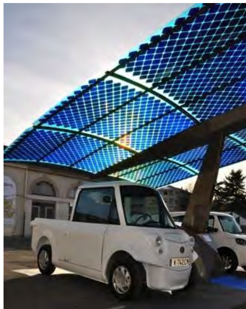
Ombrière photovoltaïque sur un parking Source internet
