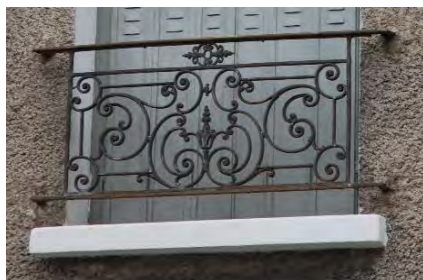
éléments de ferronnerie anciens de grande qualité à conserver impérativement lors de la restauration des édifices
