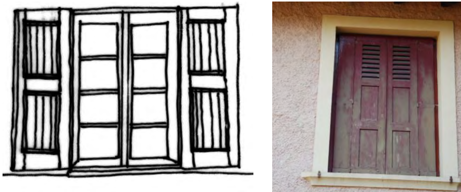
modèles de volets à cadre, dits également vole « dauphinois », pouvant être également persiennés dans leur partie supérieures
