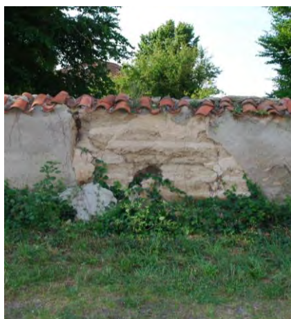
exemple de mur en pisé nécessitant d'être enduit à la chaux...
