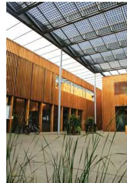
Pare-soleil photovoltaïque sur une cour Source internet
