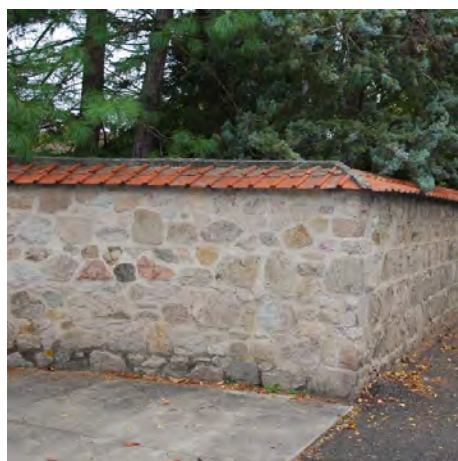
exemple de mur en pierres grossièrement équarries sur un face et rejointoyé pouvant être laissé apparent...
