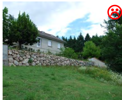
exemples d'encrochement de type cyclopéen proscrits...
