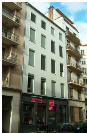
Exemple d'un immeuble isolé par l'extérieur à Lyon
