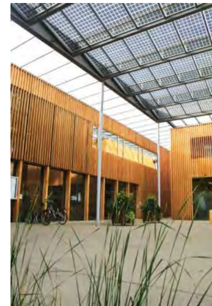
Pare-soleil photovoltaïque sur une cour Source internet
