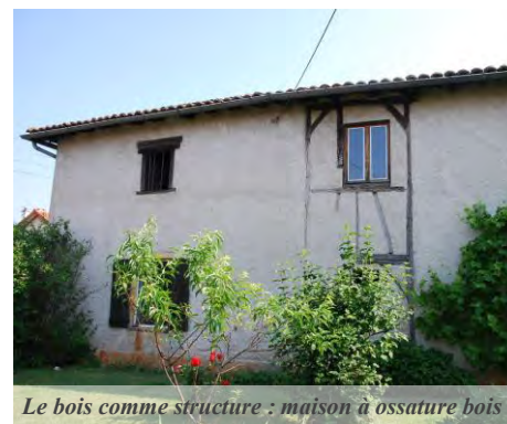
L'architecture vernaculaire de la région est souvent une combinaison de bois, de terre-cuite et de pisé
