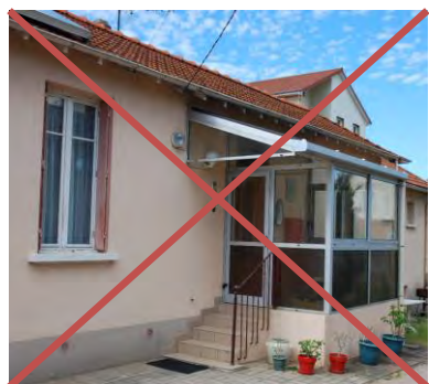
exemple de véranda « lourde » dénaturant l'architecture...
