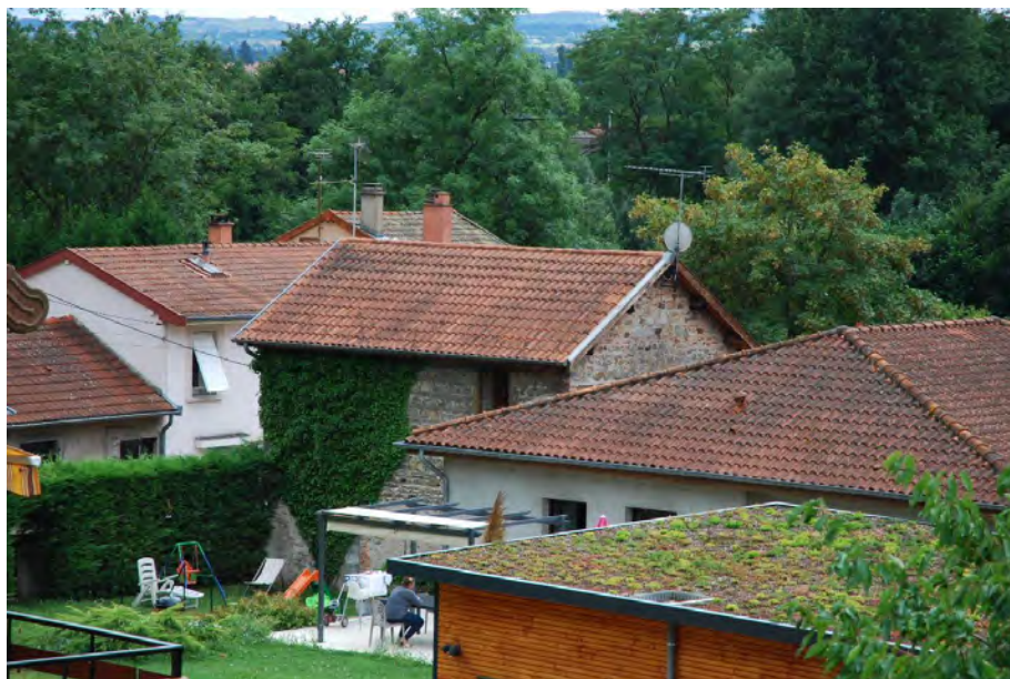
les toitures de Riorges sont essentiellement couvertes en tuiles de terres cuites plates, encore appelées tuiles mécaniques...
