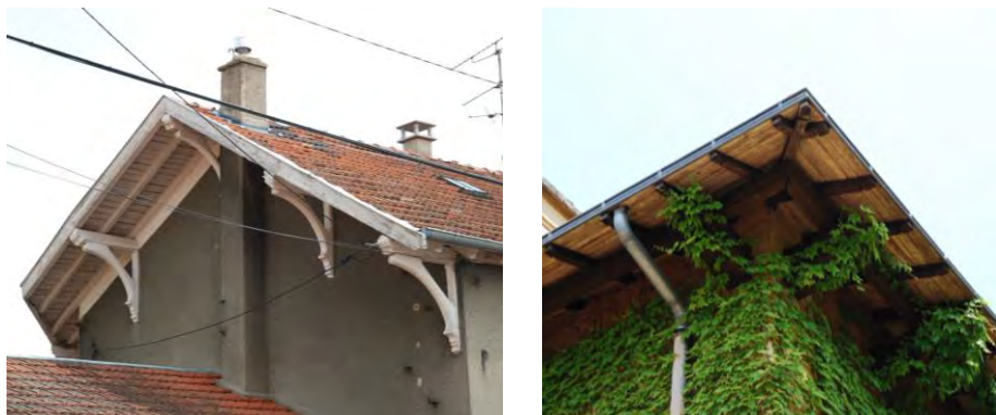
dépassés de toiture traditionnelles avec consoles ouvragées ou chevrons débordants laissant apparente la structure de la couverture
