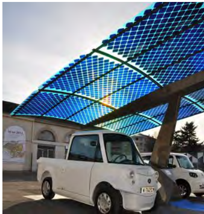
« ombrières » photovoltaïques sur un parking
