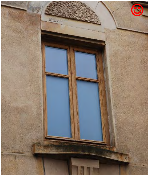
Il est essentiel que chaque menuiserie s'adapte parfaitement à la baie qu'elle occupe. La pose en « rénovation » dans l'ancien cadre, doit être évitée
