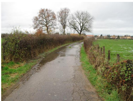
Fig. 38. Inondation – chemin de Plaines
