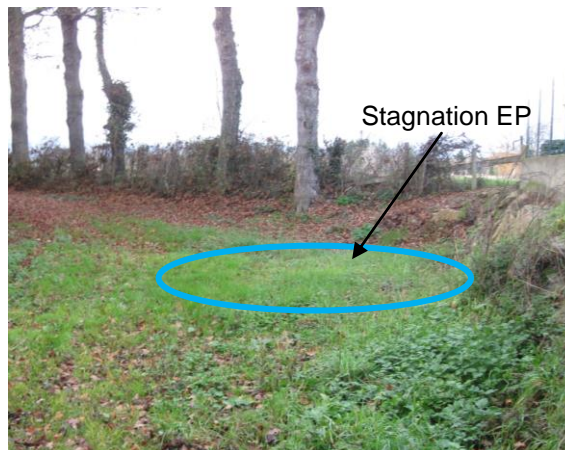
Fig. 26. Stagnation des eaux pluviales – Chemin Malefosse
